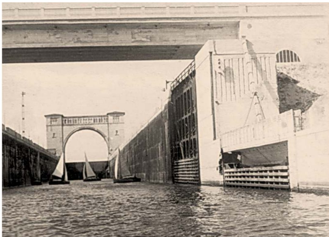
Углический шлюз. Июль 1947г.
